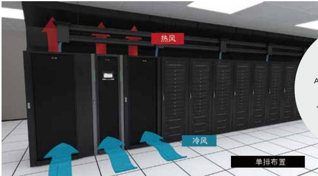
正面进风、上面出风还使 ARRAY 3A3 PT 非常适合采用细长通风道的成排布置。
