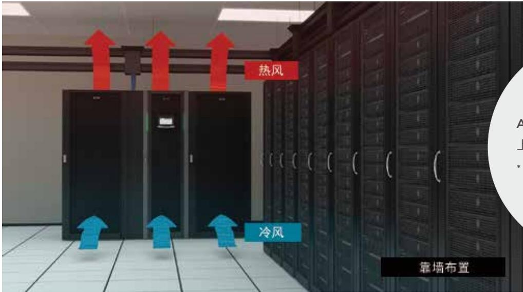
ARRAY 3A3 PT 支持正面进风、上面出风, 非常适合靠墙布置。
