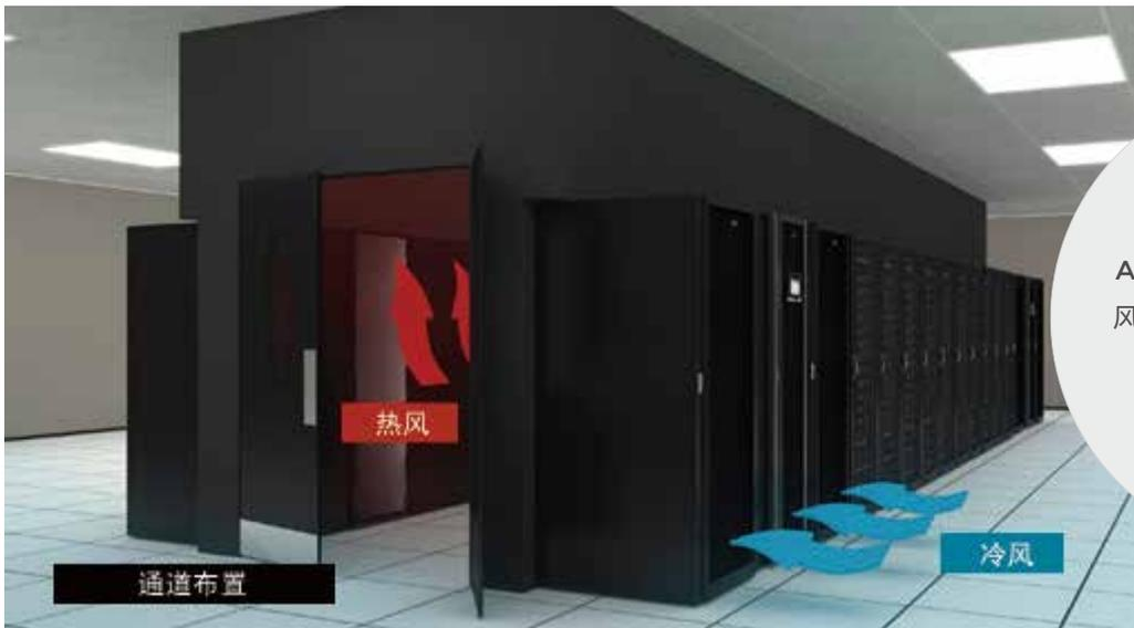
ARRAY 3A3 PT 还支持正面进风、后面出风, 非常适合热/冷通道布置。
